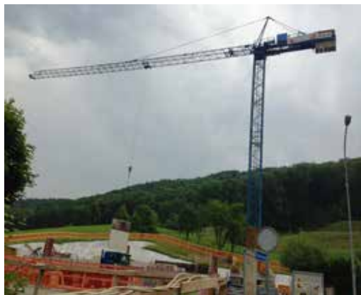
Schalung der Wände für den Neubau Kinderkrippe Stallikon
