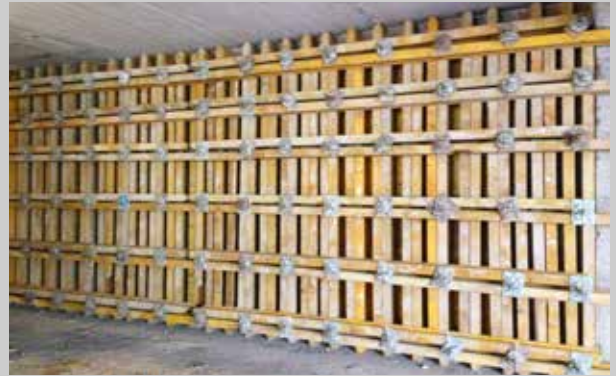
Errichtung der Erdbebenwände
