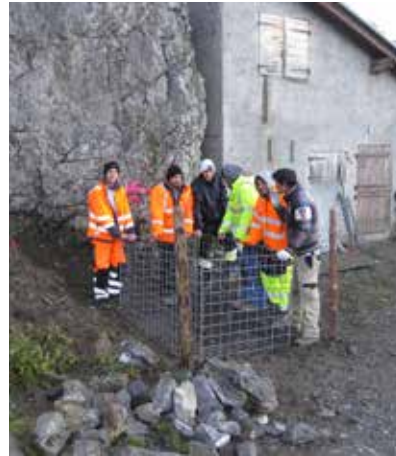
Aufstellen der Steinkörbe zum Schutz vor Lawinen
