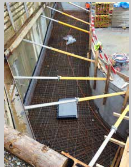
Komplexe Erweiterung mit speziellen Winkeln und 1.20 m dicken Betondecken
