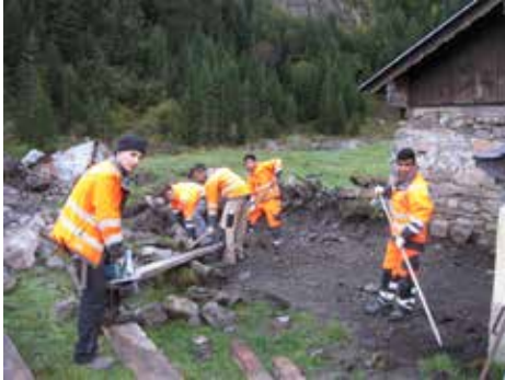
Einmessen der Bodenplatten
