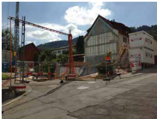
Dieser Ersatzneubau entsteht direkt neben einer denkmalgeschützten Scheune.
