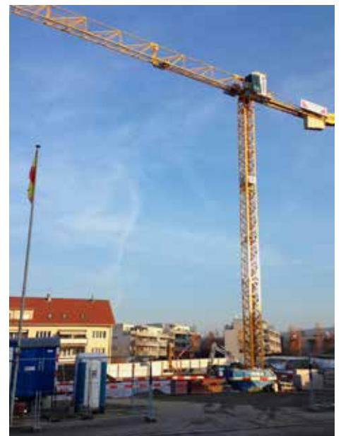
Der erste von zwei Kranen ist gestellt.
