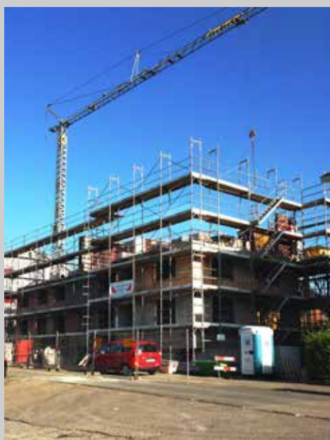
Hier entsteht ein Mehrfamilienhaus mit acht Wohnungen.
