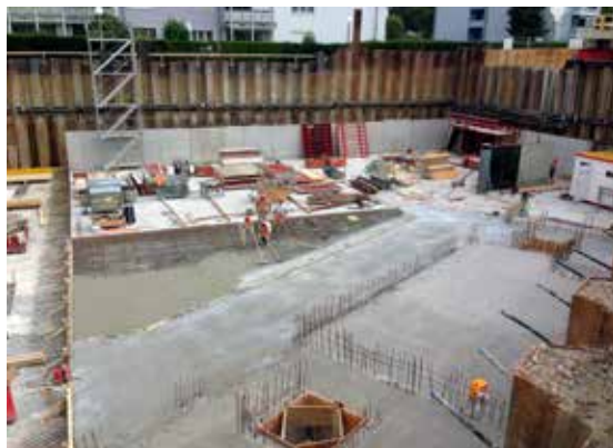
Beim Betonieren der Bodenplatten auf der Baustelle Spitzacker in Urdorf. Sowohl die Bodenplatten wie auch die Aussenwände sind aus einem speziell abdichtenden Beton.
