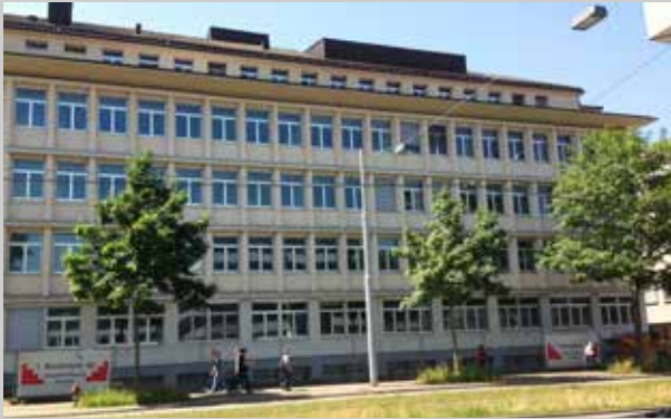
Aufstockung an der Badenerstrasse in Zürich
