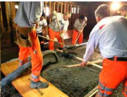
Beim Betonieren der Abflussgruben.
