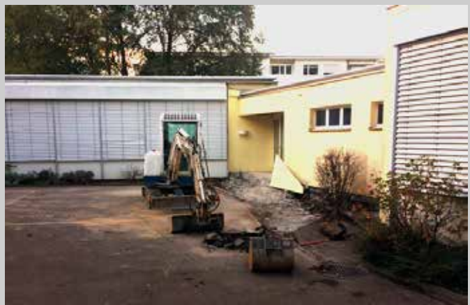
Demontage des Eingangs und anschliessend Bau einer neuen Bodenplatte mit Rampe.
