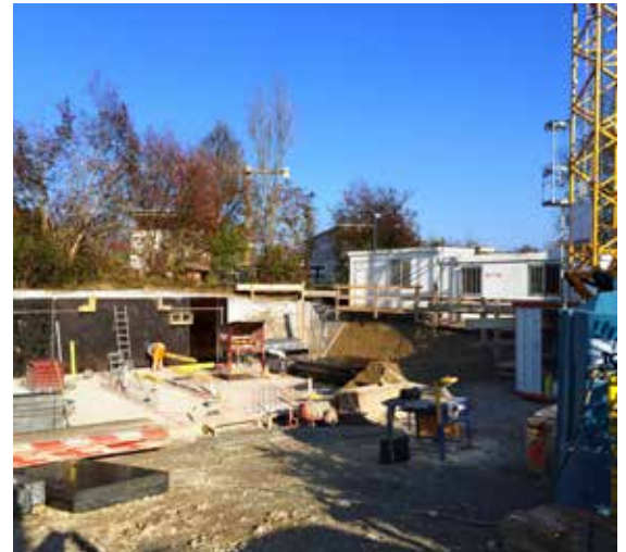
Hier entsteht ein Mehrfamilienhaus mit sechs Wohnungen und einer Tiefgarage.
