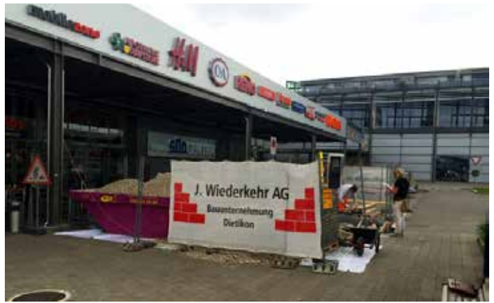
Erstellung des Fundaments für Postmodule (Bülach).
