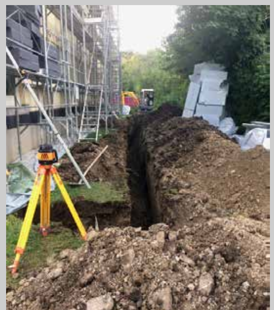
Kanalaushub für die Entwässerung.
