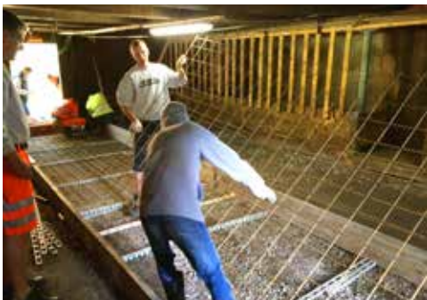
Beim Verlegen der Armierungsnetze.
