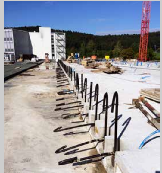
Vorspannarbeiten nach dem System VSL auf dem Dach des Zentrums Spitzacker.
