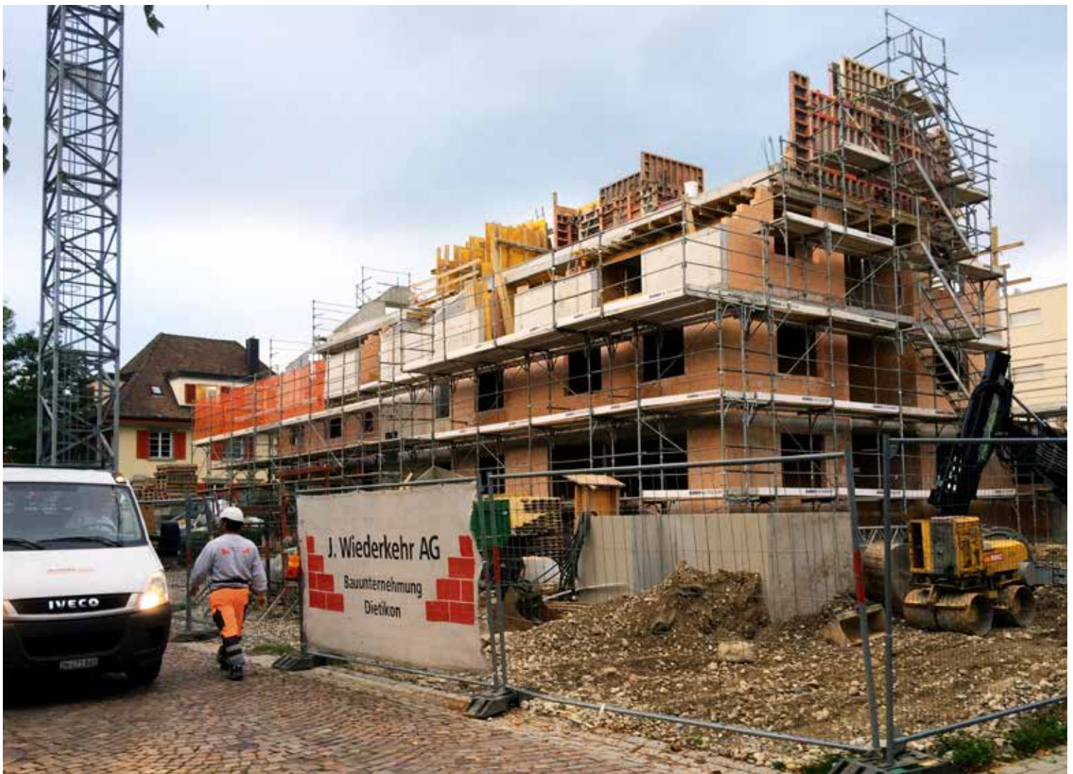
Neubau Mehrfamilienhaus Bühlstasse, Dietikon
