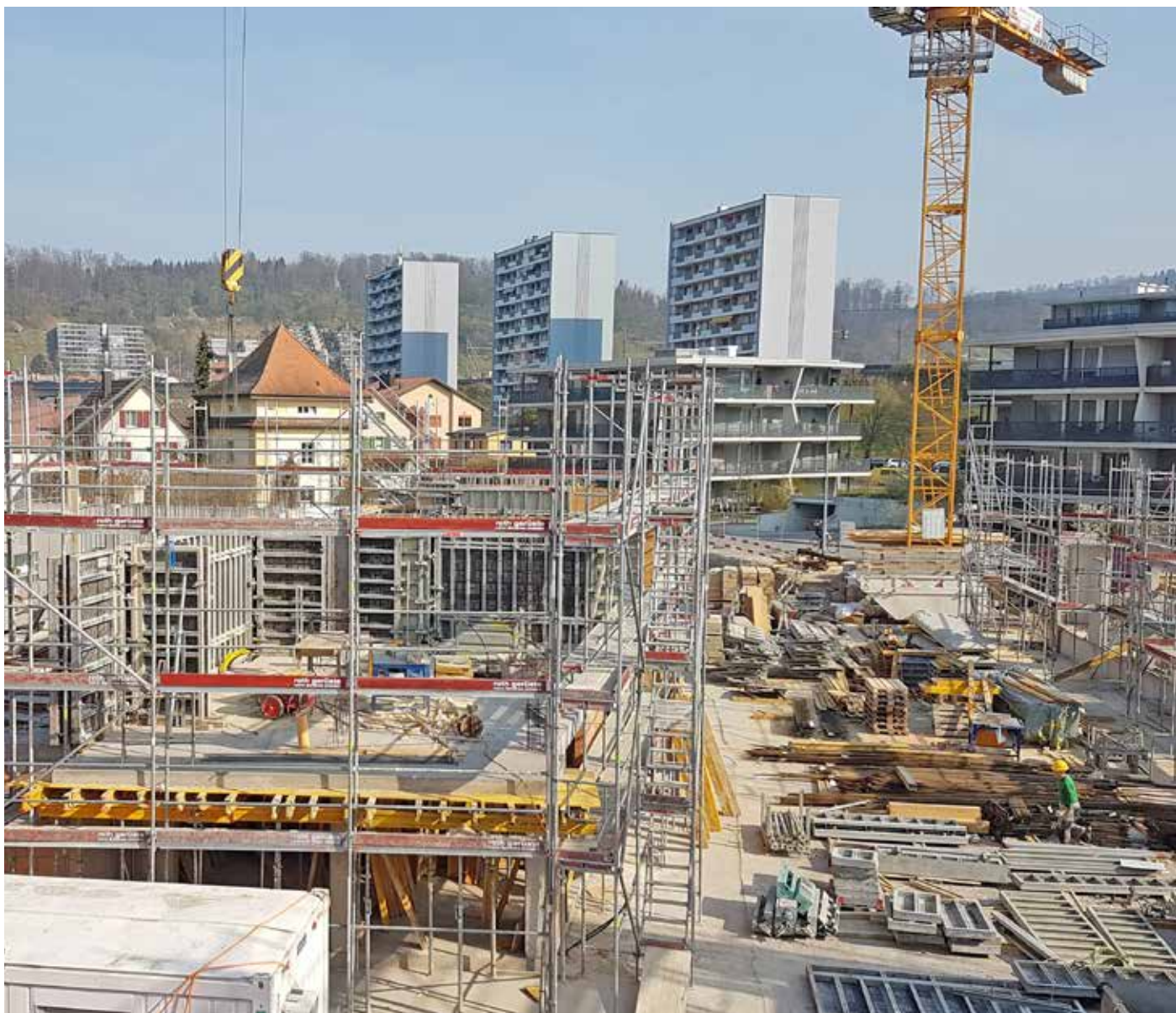
Neubau Mehrfamilienhaus Obergrüt, Brugg
