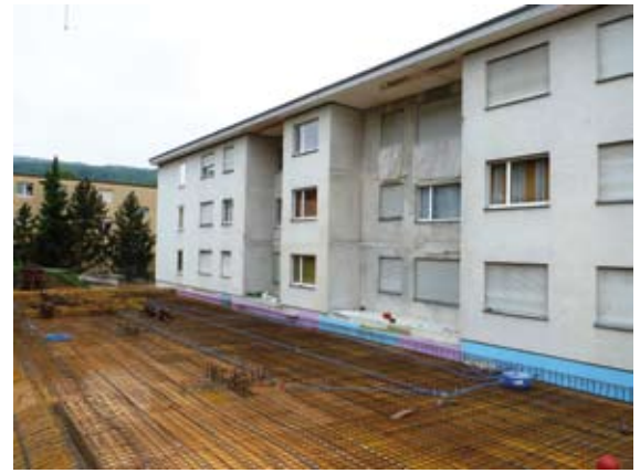
Dieser Auftrag umfasst verschiedene Abbrucharbeiten, die Erstellung neuer Balkone und den Neubau einer Tiefgarage.
