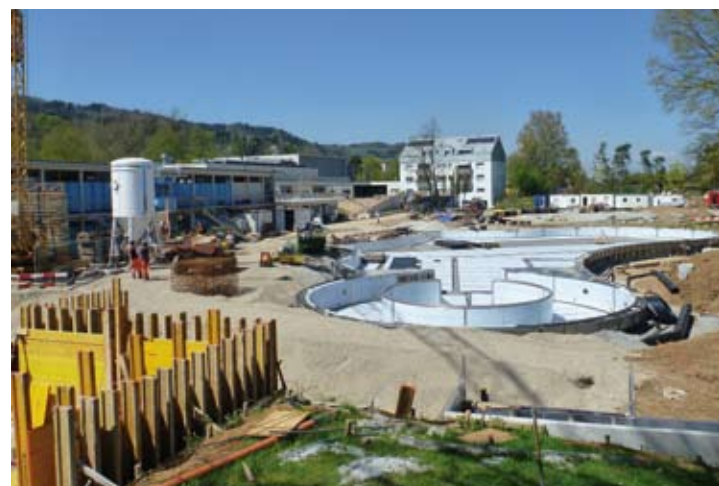
Bei diesem Auftrag dürfen wir die gesamten Umgestaltungs- und Sanierungsarbeiten des Freibads Fondli durchführen. So wurde z.B. der Sprungturm abgebrochen und erneuert, das Sprungturmbecken mit einem Chromstahlblech verkleidet und das Schwimmerbecken vergrössert. Auf diesem und dem unteren Bild sieht man das neue Nichtschwimmerbecken.
