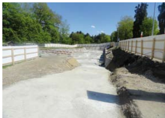
Hier entsteht ein Mehrfamilienhaus mit vier Stockwerken und einer Tiefgarage.
