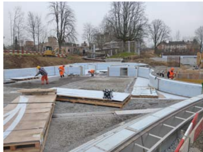
Bei diesem Auftrag dürfen wir die gesamten Umgestaltungs- und Sanierungsarbeiten des Freibads Fondli durchführen. So wurde z.B. der Sprungturm abgebrochen und erneuert, das Sprungturmbecken mit einem Chromstahlblech verkleidet und das Schwimmerbecken vergrössert. Auf diesem und dem unteren Bild sieht man das neue Nichtschwimmerbecken.
