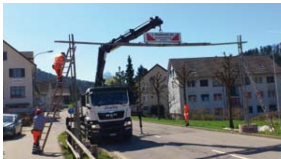
Montage einer Strassenüberbrückung für die Stromzuleitung der Baustelle.
