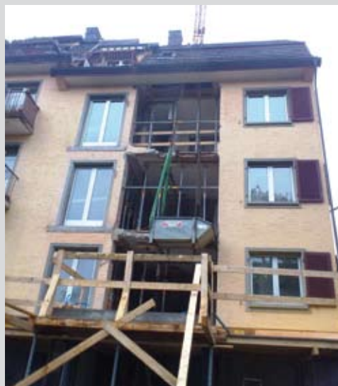
Der Auftrag beinhaltet eine umfassende Sanierung und Erneuerung des MFH sowie die Erstellung von neuen Balkonen.
